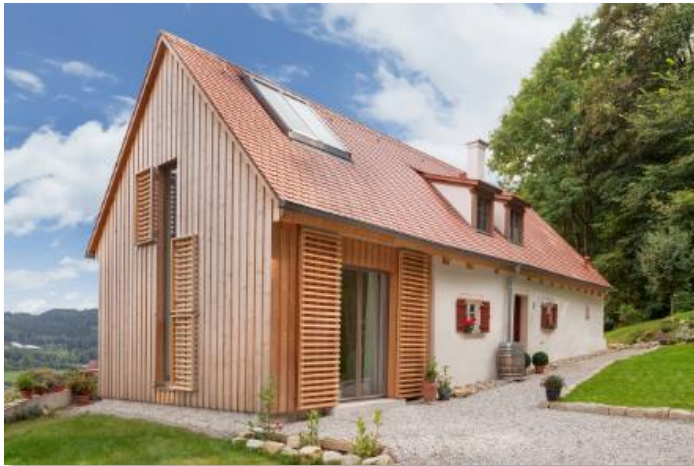
Instandsetzung und Wiederbelebung des ehemaligen Oberpfälzer Kleinbauernhauses aus dem Jahre 1730
