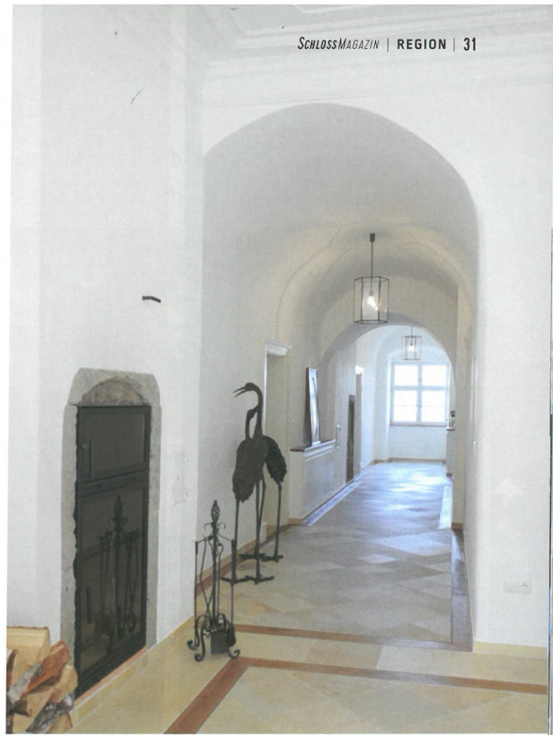
VERDECKTES UND VERBAUTES wurde wieder frei gelegt.
